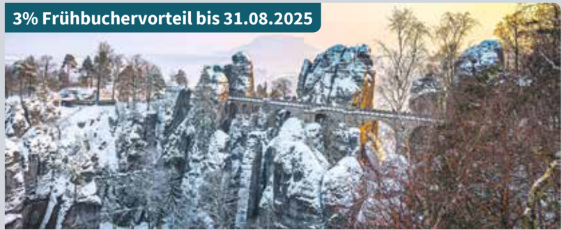
Basteibrücke im Winter
