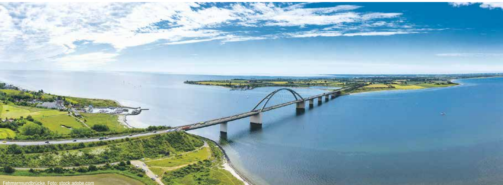
Fehmarnsundbrücke, Foto: stock.adobe.com
